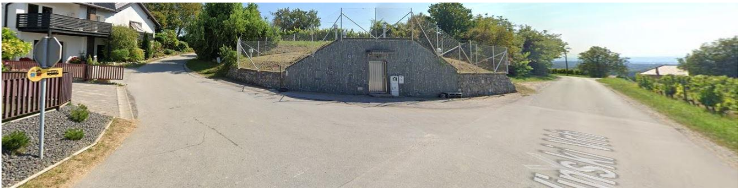
Vinski Vrh 24 (vodohran)
